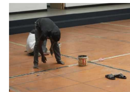
プラザの床パッキン補修作業の様子
